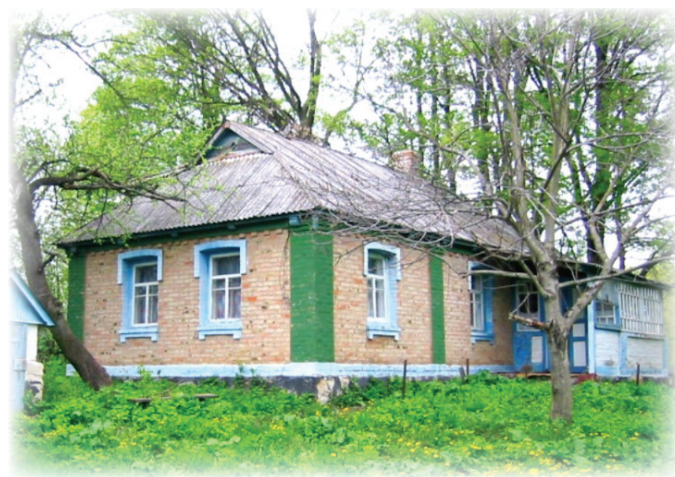
Рис.7. Облицьована цегляною кладкою глиняна хата в селі Зелене. (фото В. Савйовський)
