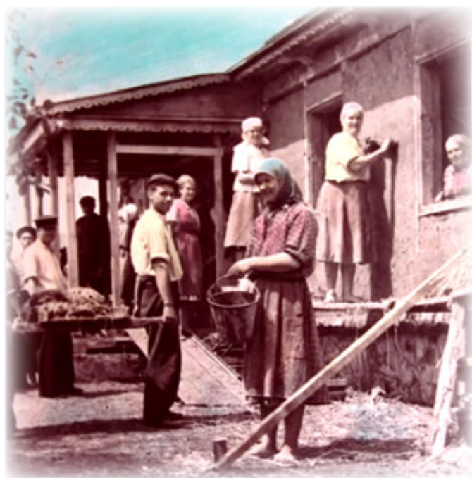
Рис. 5. Толока. Заповнення каркасу стін глиняно-солом'яним розчином. Село Немиринці, 1957 рік. (фото надано Б. Максименко)
