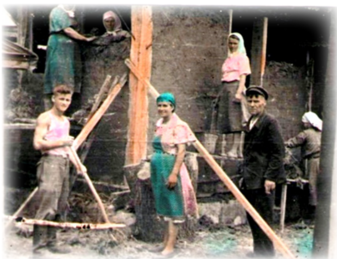
Рис. 6. Т. Влаштування стін з глиняно-солом'яного розчину («мастили» стіни). Село Немиринці, 1957 рік. (фото надано Б. Максименко)
