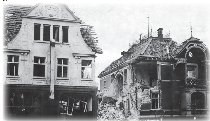
Folgen des Fliegerangriffs auf Lange Straße in Lünen-Süd, 1944;
