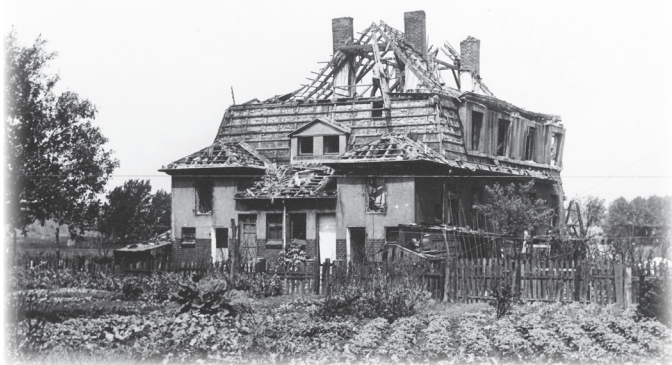
Folgen des Luftangriffs auf Niersteheide in Lünen-Süd, 1943;
